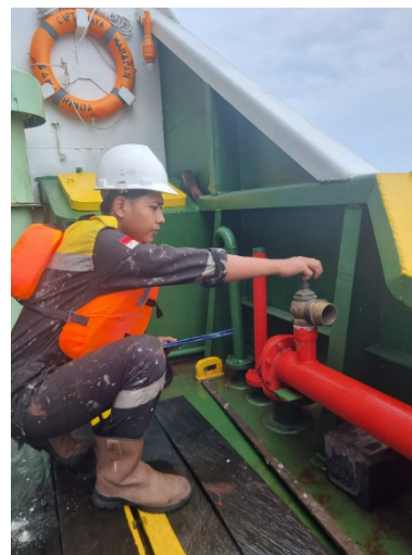
Pemeriksaan sambungan pipa hydrant
